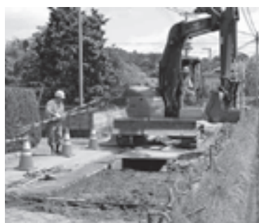
▲下水道工事(野蒜地区)
