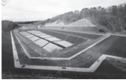
▲東松島市一般廃棄物最終処分場(大塩字旗沢)全景
