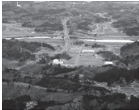
▲ひびき工業団地を仙台側から望む
