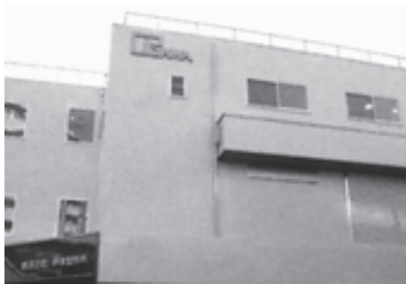
▲(株)伊澤製作所本社工場の外観
