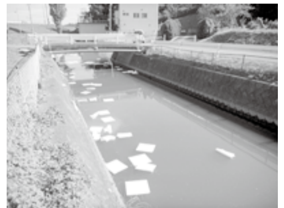
▲吸着マットで油流出事故処理
