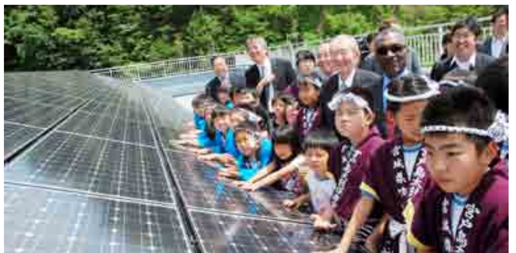
▲コカ・コーラ教育・環境財団の復興支援基金を活用した宮戸小学校の太陽光発電装置が完成し、記念セレモニーが行われました。太陽光発電で校内で必要な電力を確保します(7月9日)
