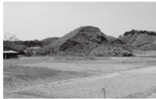
◀集団移転先となる牛網団地造成工事の様子(5月9日現在)
