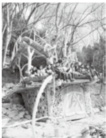
4月13日(土)には建設中のツリーハウスとその周辺で、森づくりワークショップが行われました
