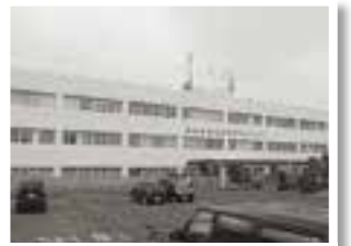
▲東松島市役所本庁舎・東庁舎
