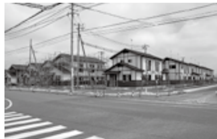
▲8月現在の工事状況
