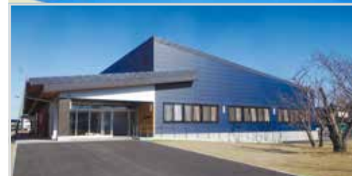
▲完成した体育館
