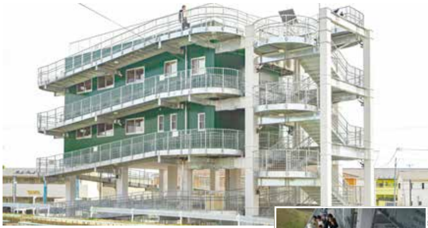
▲完成した避難タワー
