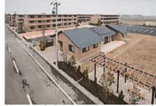
C: 小松南災害公営住宅 集合住宅156戸 平成26.4.1入居
