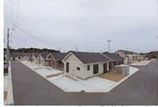
B: 沢田前災害公営住宅 戸建41戸 平成28.3.8入居
