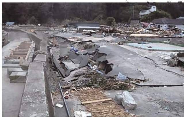
▲宮戸月浜地区 堤防も破壊され住宅も流出
