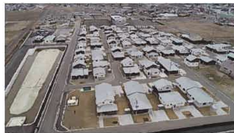
H: 柳の日西災害公営住宅 戸建住宅100戸 平成31.3.24入居
