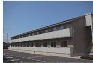
F: 川前二災害公営住宅 集合住宅16戸 平成26.4.1入居
