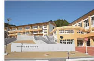
⑪鳴瀬未来中学校
