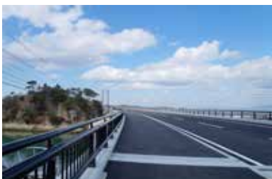
2021年3月に供用開始された松ヶ島橋
