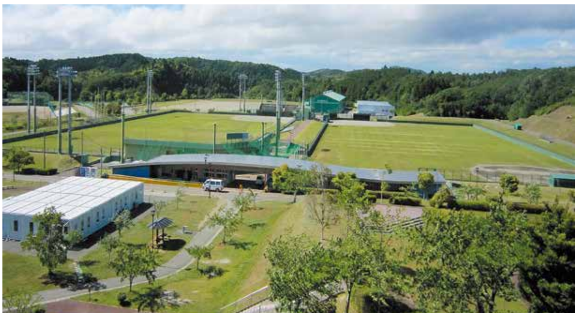
鷹来の森運動公園には防災備蓄倉庫を整備しました
