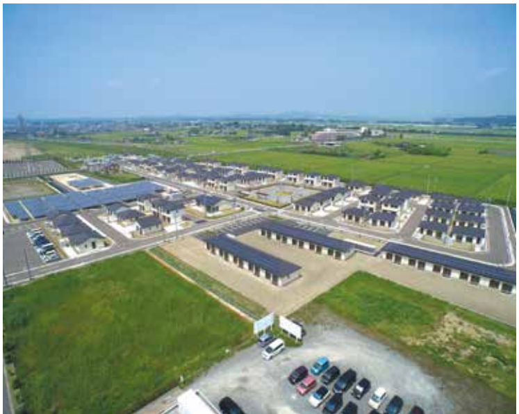
柳の目スマート防災エコタウン全景
