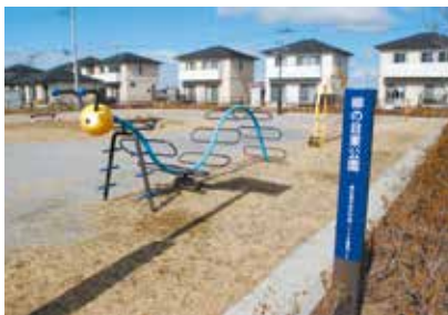
戸建てタイプの2階建て災害公営住宅
