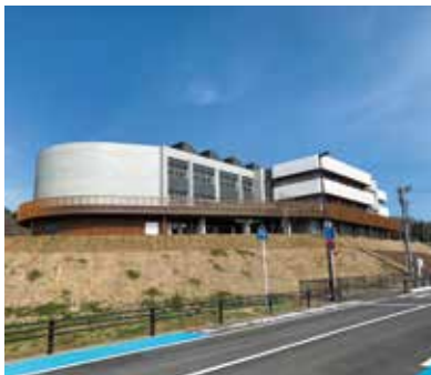
小野地区の高台に建設した鳴瀬桜華小
