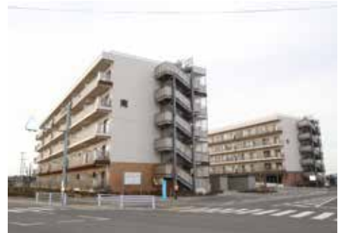
現在の矢本東地区(市営あおい住宅)
