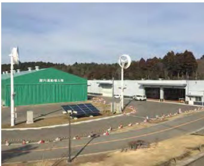
防災拠点備蓄基地
