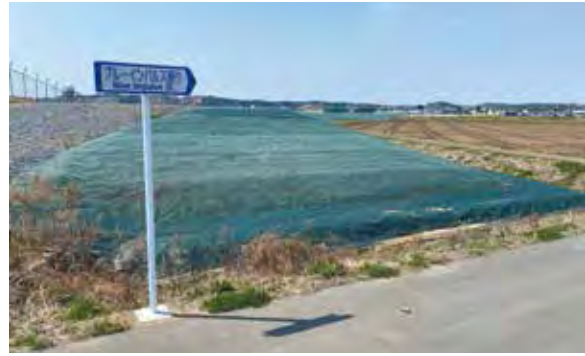
矢本防災盛土
