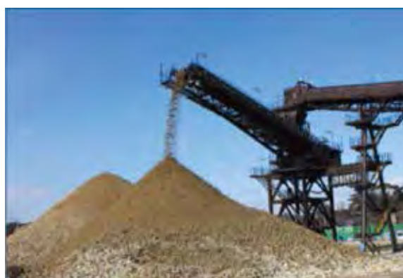
ベルトコンベアを活用し、一気に土砂を運搬
