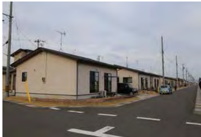
矢本西地区災害公営住宅団地
