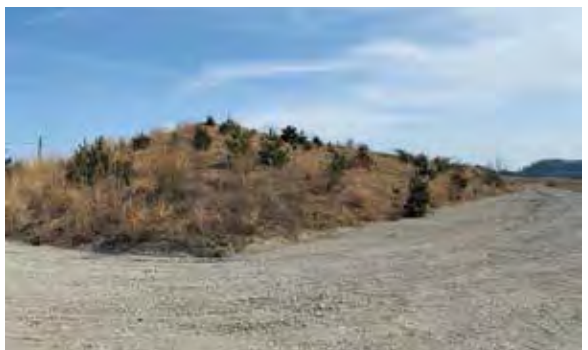
松ヶ島防災盛土
