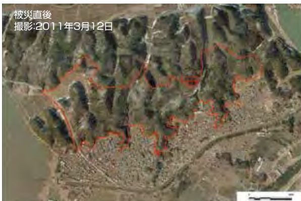
被災直後の航空写真。山地となっている赤線内が野蒜ヶ丘地区
