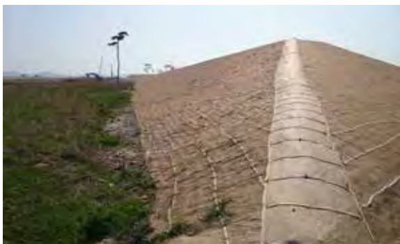
北上運河防災盛土
