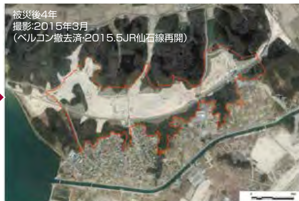
切土と造成を終えた直後の航空写真。南北の道路も完成している
