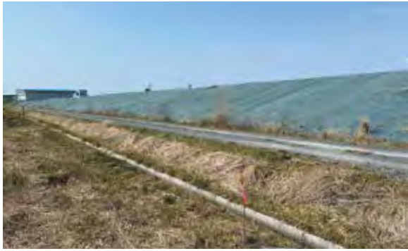
矢本防災盛土
