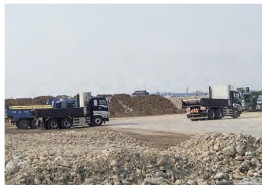
野蒜ヶ丘地区の切土の流用、小松地区の土砂の使用、大曲浜地区での盛土作業
