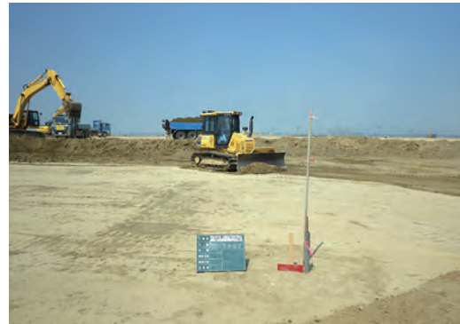
施工途中 平成29年7月10日
