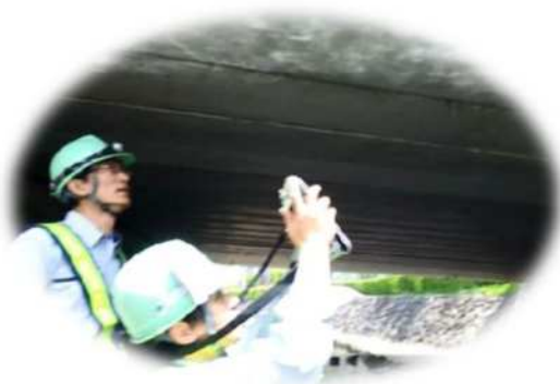
【タブレットによる点検】
