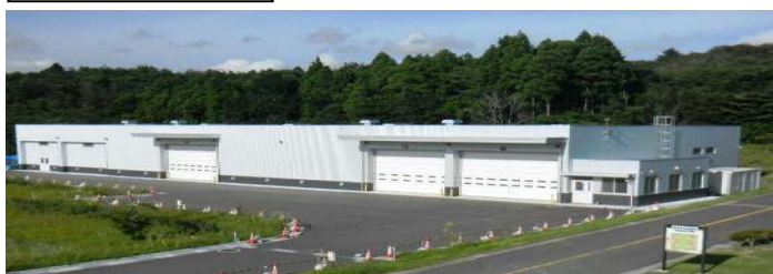
防災拠点備蓄基地
