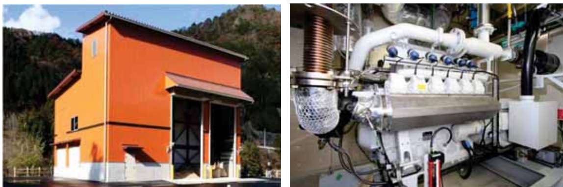
図表 1-50 木質チップ燃料によるガス化エンジン式コジェネシステムの例 25
