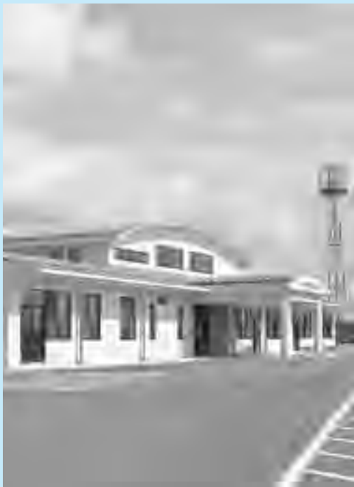
▲施設の維持修繕管理を行画的に行います(写真は大曲地区コミュニティセンター)
