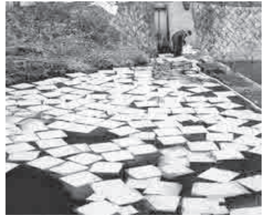
油吸収シートでの除去作業
