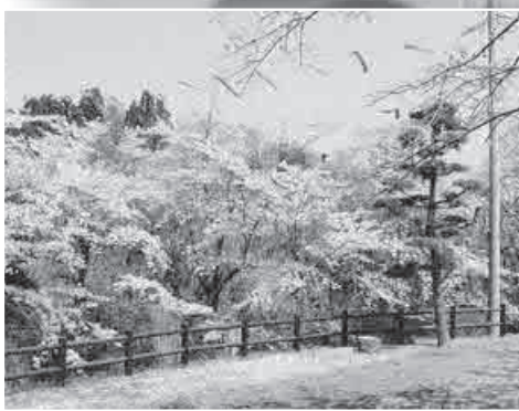
三陸自動車道
