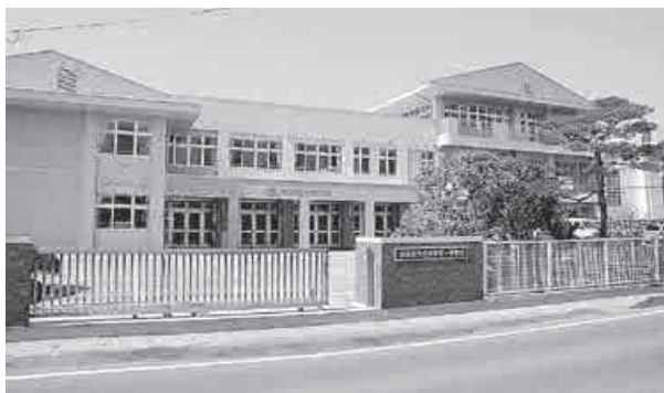
▲矢本一中の新校舎を正門から
