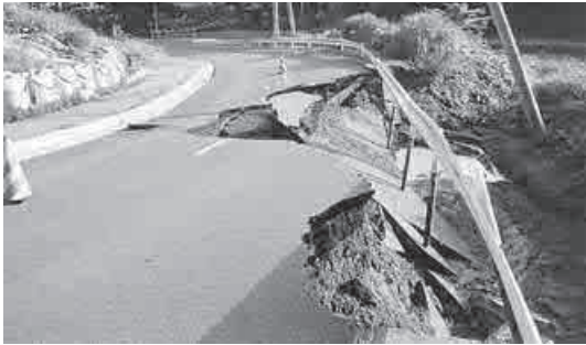
宮城県北部連続地震災害復旧事業
