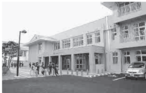
矢本第一中学校危険改築及び防音工事
