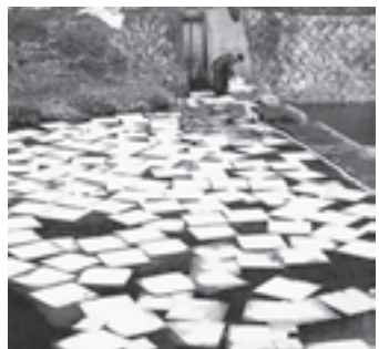
▲吸着マットで油流出事故処理
