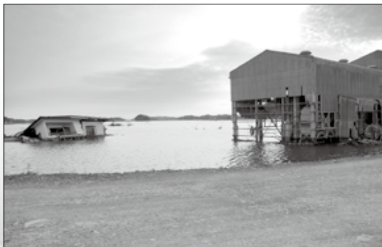
▼海の中に残るライスセンター（平成24年9月8日撮影）
