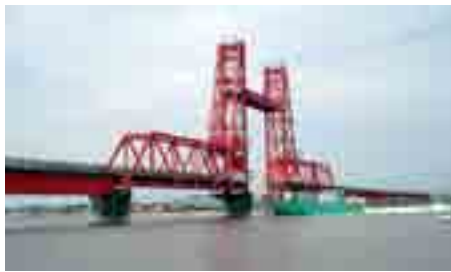
▲筑後川昇開橋(旧筑後川橋梁) 1935年(昭和10年)旧国鉄佐賀線の鉄橋として筑後川河口に架設された全長507mにもおよぶ東洋一の可動式鉄橋で、現存する可動橋では全国で最古のものです。中央部の可動桁が上がり、船が航行できるようになっています。国指定重要文化財指定、日本機械学会の「機械遺産」認定。
