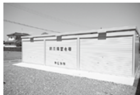
▶平成24年度に新築した地域防災備蓄倉庫
