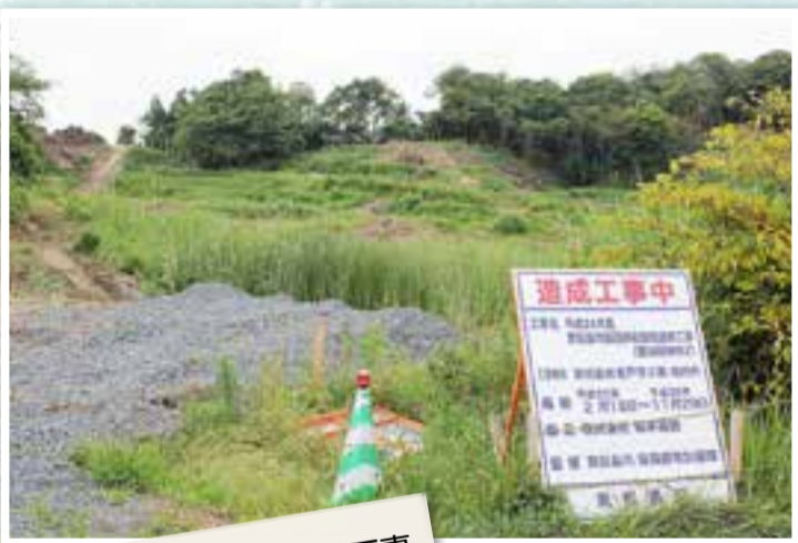
月浜団地造成工事 (7月時点)
