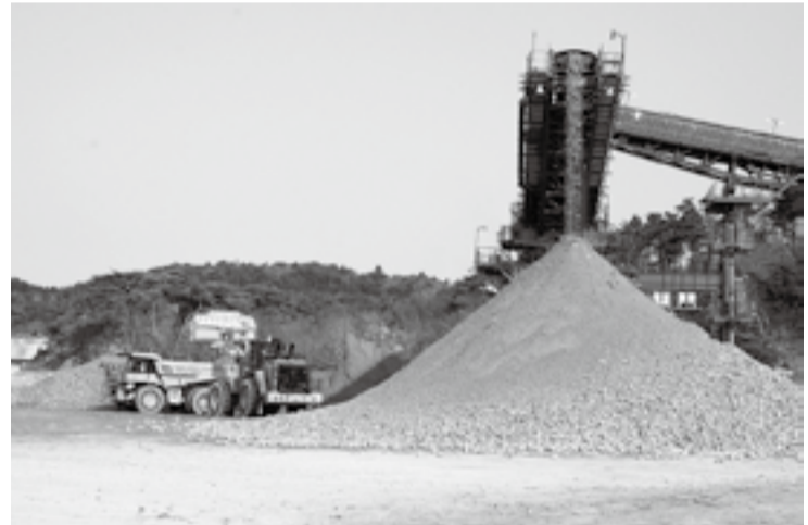
▶野蒜北部丘陵団地の造成工事で発生した残土を、大型ベルトコンベアで運び、河川沿岸の護岸工事や地盤沈下した農地などのかさ上げなどに活用(野蒜海岸付近)
