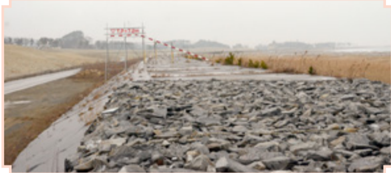
▼現在の洲崎(野蒜)海岸。新しい堤防の高さが張りりで示されています
