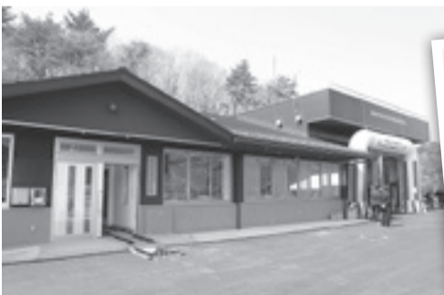
▶東松島消防署鳴瀬出張所
