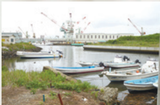
▶ 大曲地区の護岸工事についても協力を求めました
