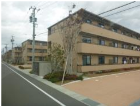
小松南地区 災害公営住宅 平成26年4月1日引き渡し。156戸(全戸入居済)。
