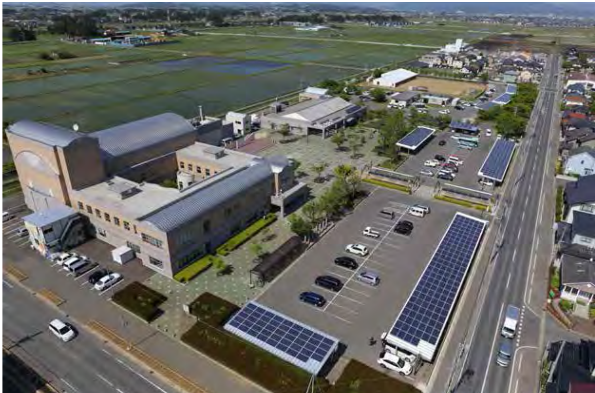
東松島「絆」カーポートソーラー (写真提供：三井物産株式会社)
