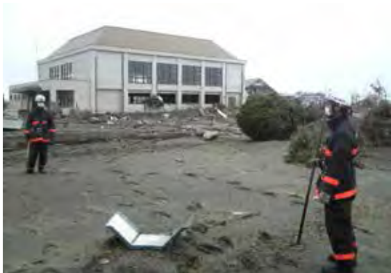
被災直後の体育館
