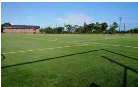
日本サッカー協会公認の多目的グラウンド
