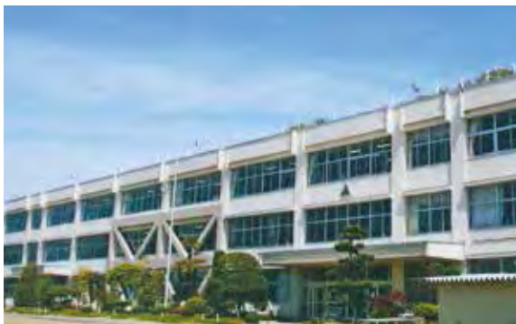
旧鳴瀬第一中学校
