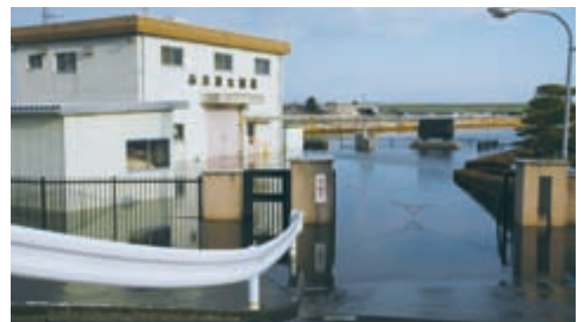
被災直後の赤井排水機場
