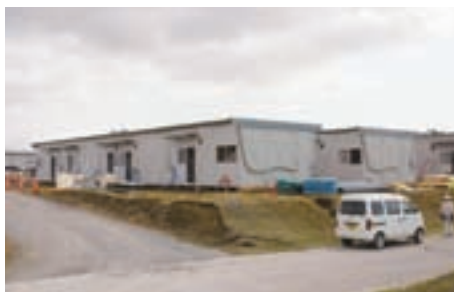
建設中のひびき工業団地仮設住宅の様子
