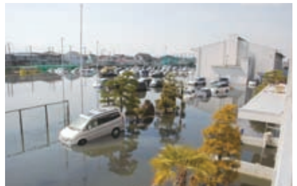
被災直後の矢本第二中学校（2011年（平成23年）3月14日）
