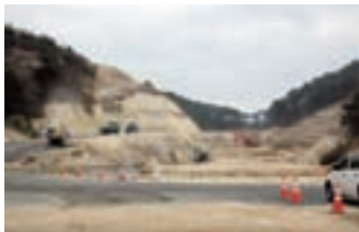
仙石線復旧工事の様子<その①>
