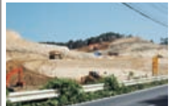
仙石線復旧工事の様子<その②>
