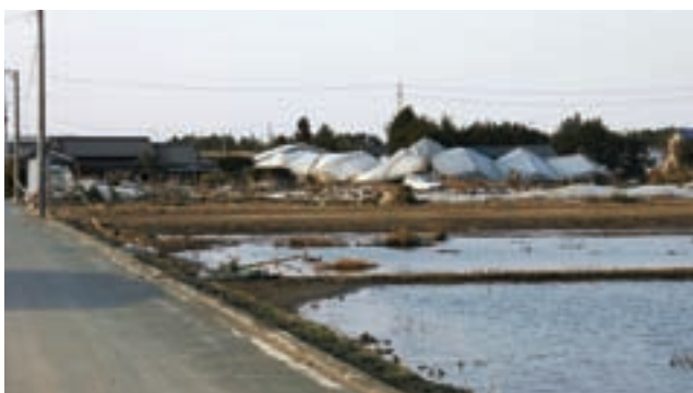
被災直後の矢本字立沼地内の園芸農業用ビニールハウス
