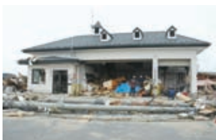
被災直後の矢本消防署鳴瀬出張所
