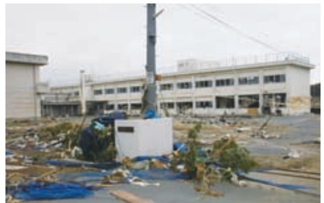
被災直後の鳴瀬第二中学校
