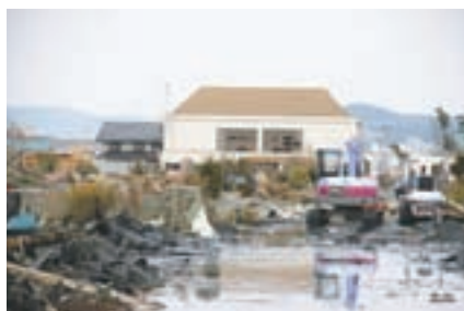
被災直後の大曲地区体育館
