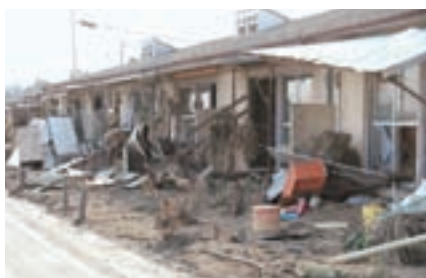
被災直後の市営立沼住宅
