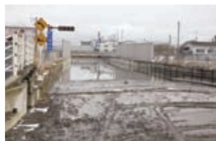
被災直後の県道矢本アンダーパス(掘下立体交差)
