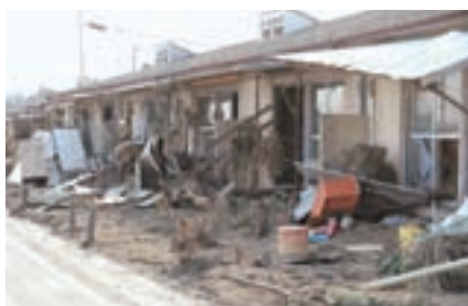
被災直後の市営立沼住宅
