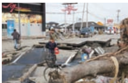
被災直後の国道45号・定川沿い
