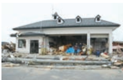
被災直後の矢本消防署鳴瀬出張所
