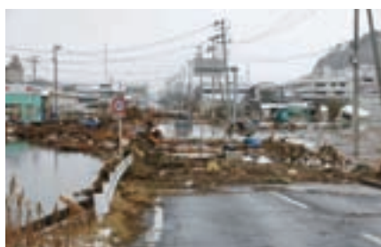
被災直後の県道小野新宮前交差点付近
