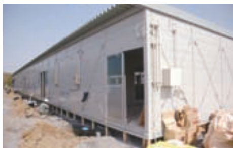
建設中のグリーンタウンやもと仮設住宅の様子
