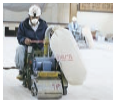
大曲小学校災害復旧工事の様子(2012年(平成24年)6月)
