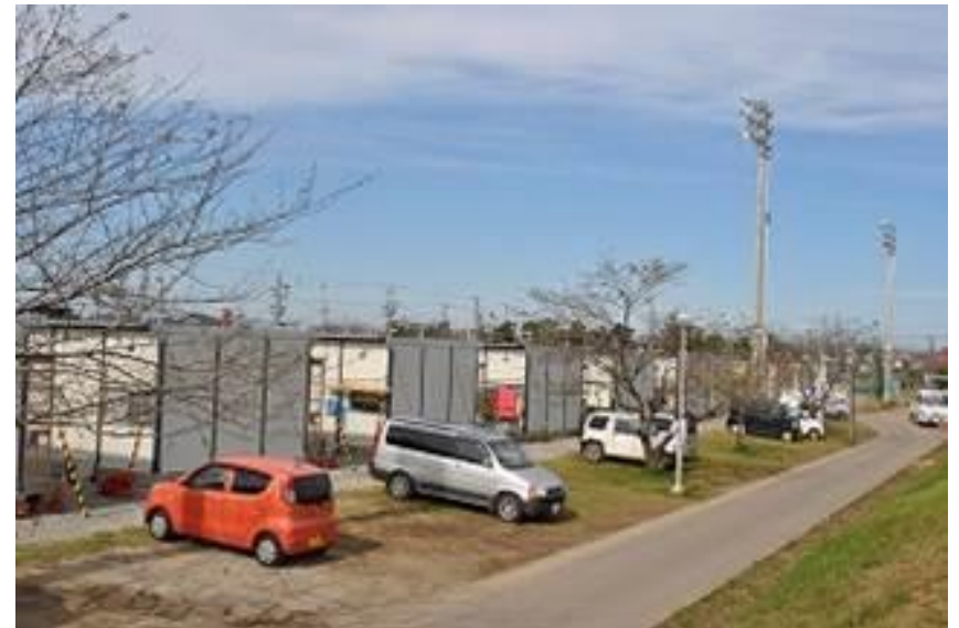
矢本運動公園に建設された応急仮設住宅の様子
