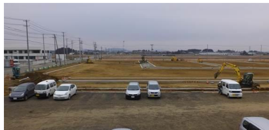
先行街区の工事が進み、もうすぐ建築工事が始まります
