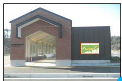
▲野蒜駅（自由通路出入口）
