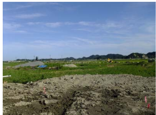
被災した農地の再整備
