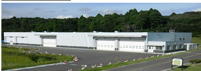
防災拠点備蓄基地
