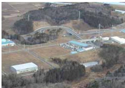
ひびき工業団地
