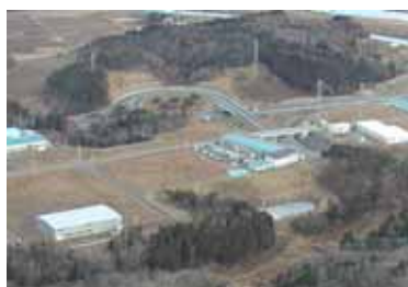
ひびき工業団地
