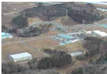
ひびき工業団地
